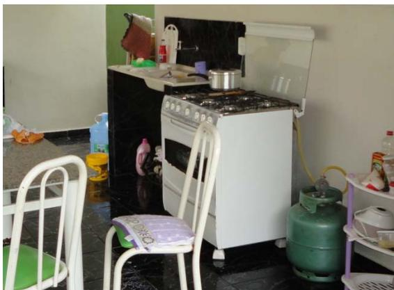
**Figura 39:** Posição do botijão de gás ao lado do fogão, na moradia “C”.
