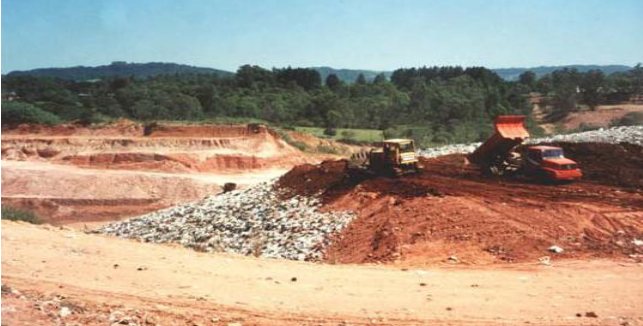
Figura 5. Cobertura intermediária dos resíduos (ao fundo, retirada de material no próprio aterro) Aterro Metropolitano Santa Tecla, Gravataí, RS.
