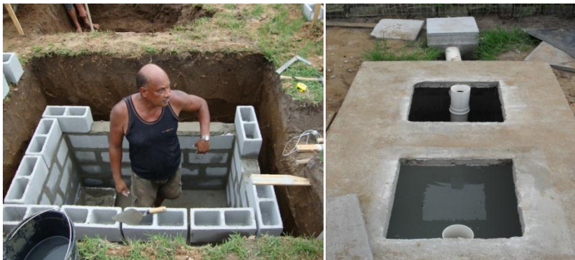
Figura 7 - Construção e impermeabilização do tanque séptico após a instalação hidráulica.
