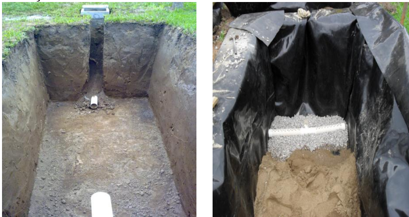
Figura 10 Escavação do FPM com detalhe da manta plástica e da tubulação de coleta do efluente.
