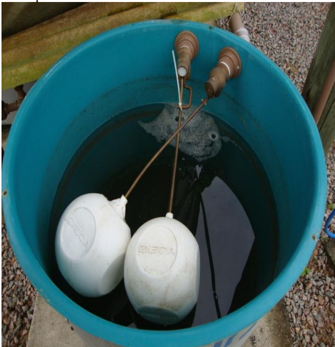
Figura 6 - Dispositivo de descarte e detalhe das torneiras bóias utilizadas.
