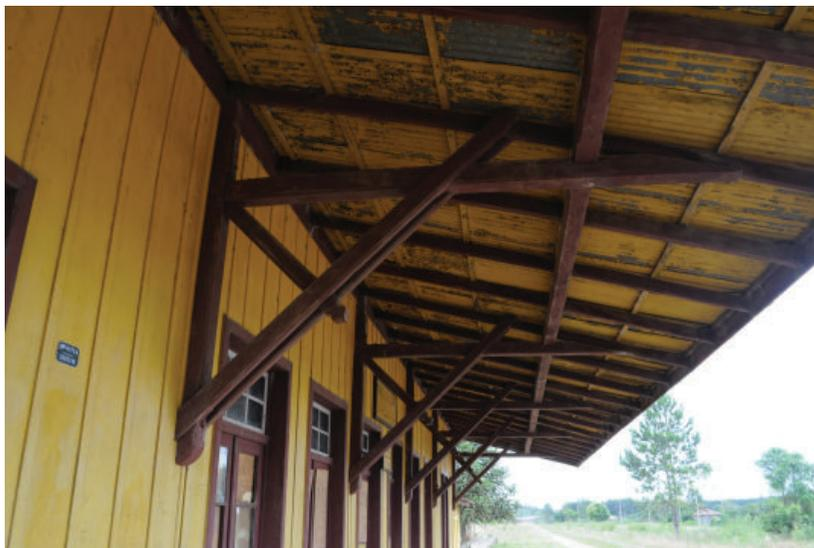
Figura 3.38: tesoura composta vencendo o vão da plataforma da estação Três Barras. Foto do autor, 2010.
