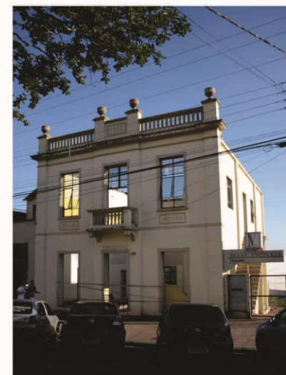
Edificação eclética inventariada no IPAC, antes de sua demolição. Foto: Simone Prestes, 2011.
