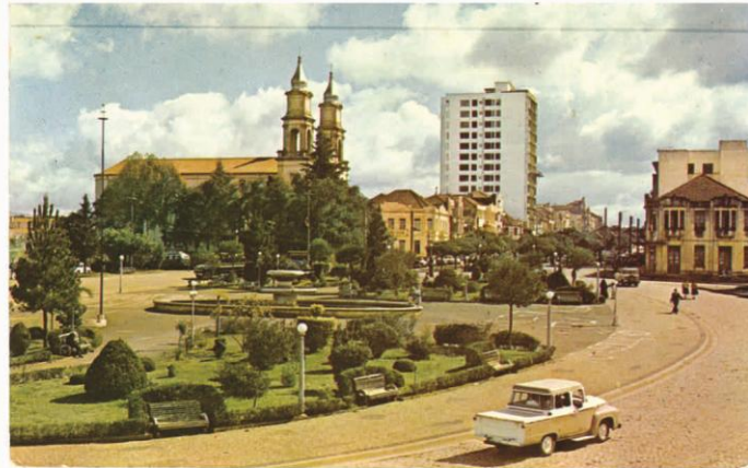
Praça central, ao fundo torres da antiga Igreja Matriz Catedral São José e Condomínio Erechim. Foto: Arquivo Histórico Municipal, sem data.
