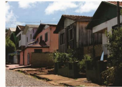
Conjunto de edificações de madeira, repetição do desenho arquitetônico. Próximas ao limite do sítio cultural. Foto: Simone Prestes, 2012.
