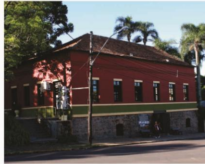
Primeira edificação de alvenaria da cidade, construída em 1912, restaurada recentemente. Foto: Simone Prestes, 2012.
