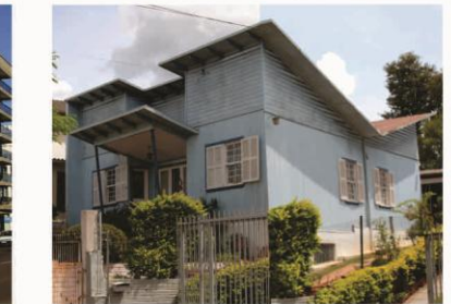
Edificação de madeira, com características modernistas. Foto: Simone Prestes, 2011.
