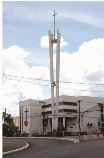
Atual Igreja Matriz Catedral São José. Arquitetura Modernista. Fotos: Simone Prestes, 2011.
