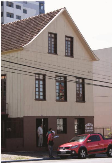
Fachada principal da Casa da Família Rigoni, no térreo alfaiataria do Sr. Luiz e barbearia. Foto: Simone Prestes, 2011.
