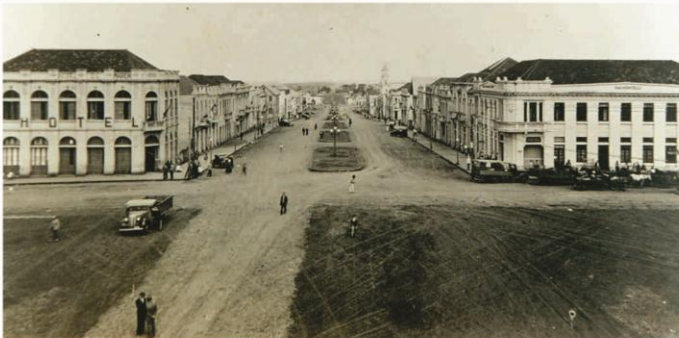
Avenida central com edificações de alvenaria, em estilo eclético. Vista desde a linha férrea. Foto: Arquivo Histórico Municipal, sem data.
