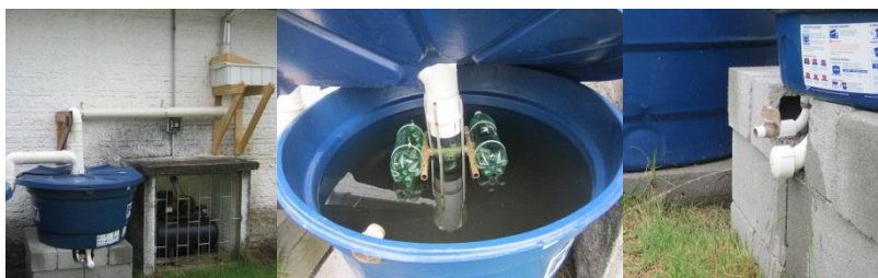
Figura 9: Fotografias do dispositivo de descarte da primeira fração da água de chuva.
