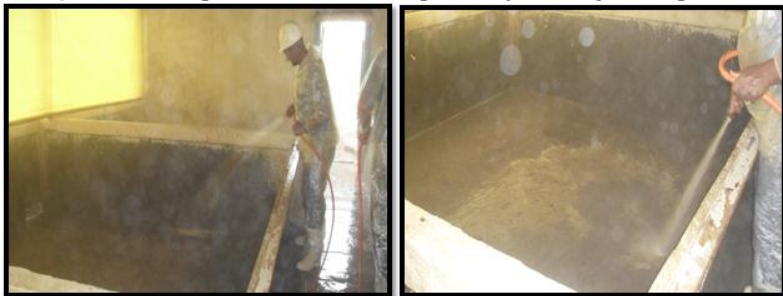
Figura 11 - Limpeza de baia com máquina de jato de água sob pressão.
