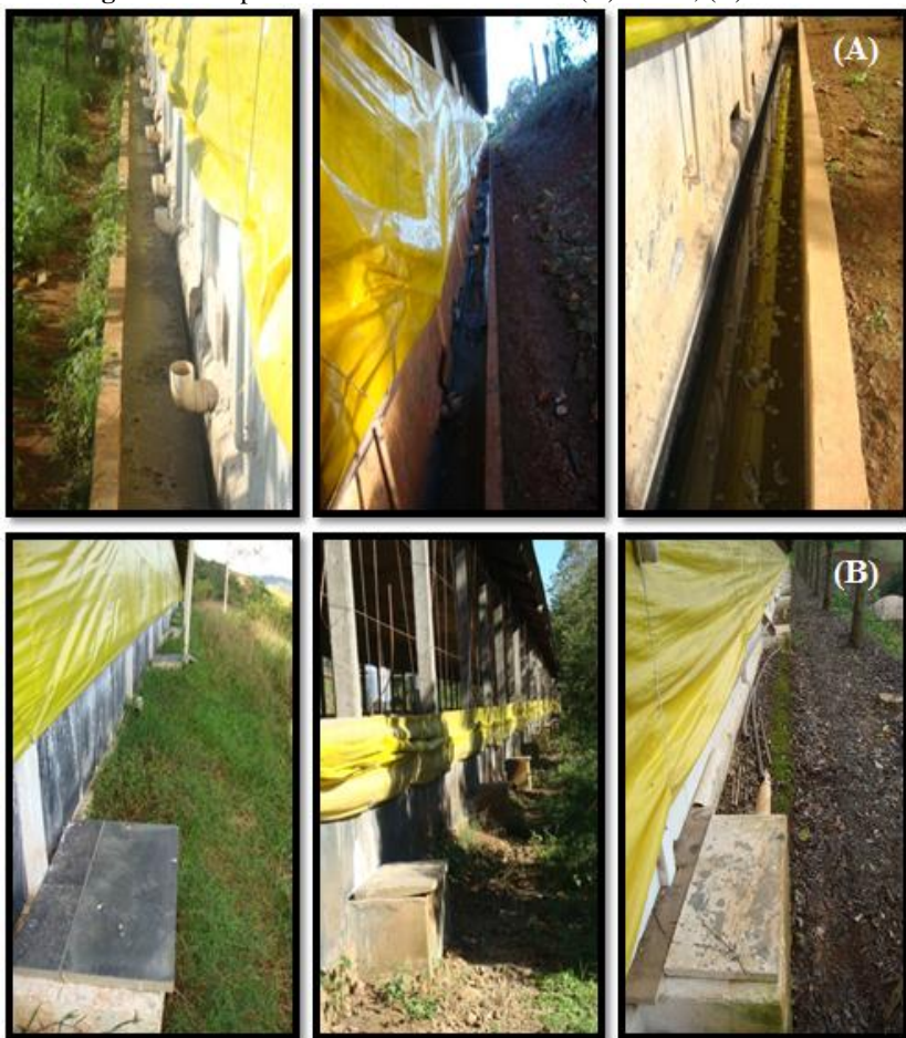
Figura 14 - Tipo de canaletas nas unidades: (A) aberta; (B) fechada.
