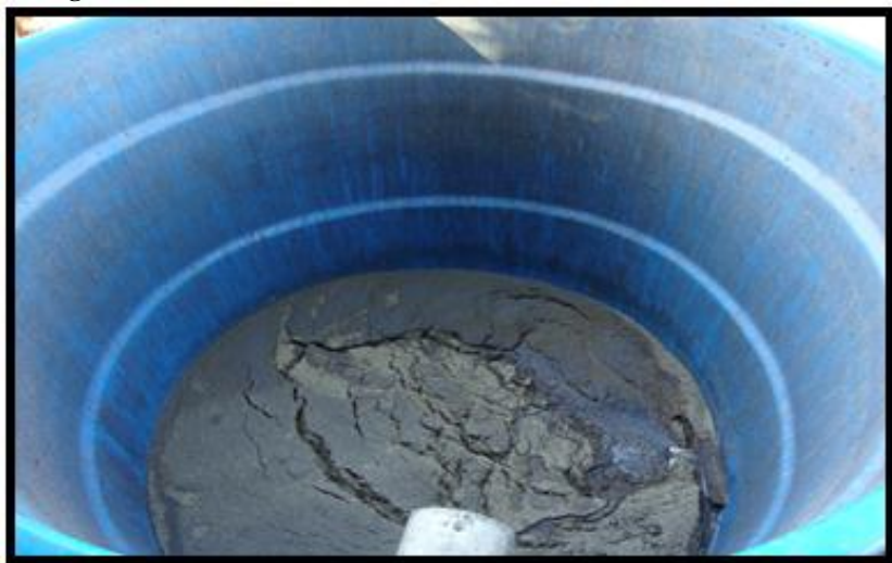
Figura 24 - Sólidos sedimentados no interior das caixas de fibra de vidro.
