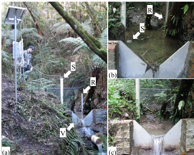
Figura 9 – Estação fluviométrica do rio Araponga. (a) Estação completa; (b) Início do monitoramento: sem a tela, folhas e galhos acumulados no vertedor; e (c) Depois de um evento de chuva intensa, a tela não é capaz de reter a grande quantidade de sedimento. Nota-se que R indica a posição da régua linimétrica, S do poço onde está instalado o sensor de pressão, e V o vertedor.
