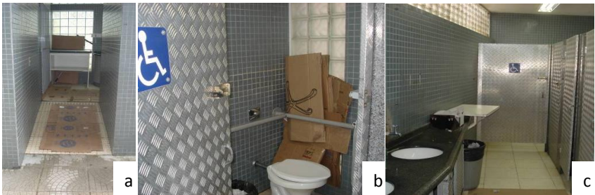
Figura 67: Sanitário do Terminal Central.
