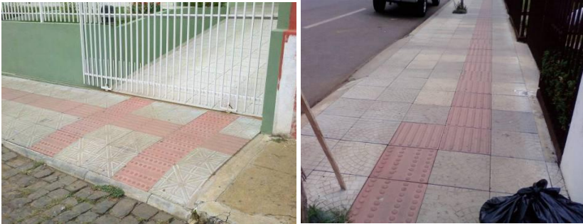
Figura 50: Pisos táteis utilizados sem conhecimento da correta aplicação. Fonte: Acervo da autora, fevereiro, 2012.
