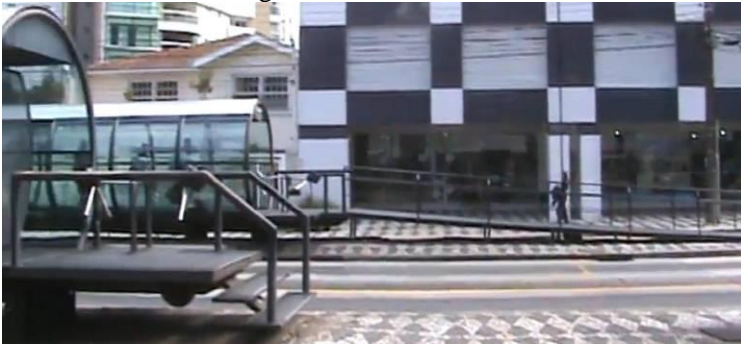
Figura 102: Rampa de acesso às estações-tubo - Curitiba-PR.
