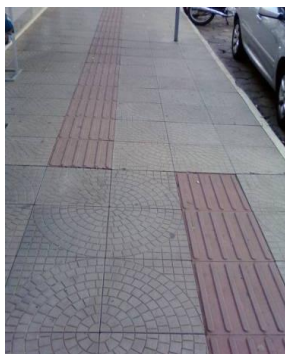
Figura 90: Descontinuidade de pisos táteis.
