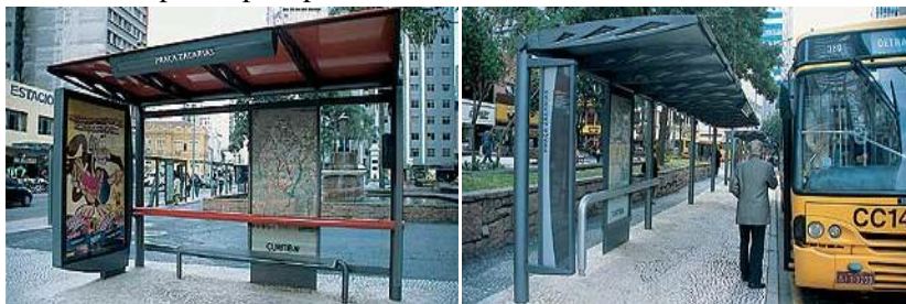
Figura 31: Abrigos de ônibus de Curitiba - PR
