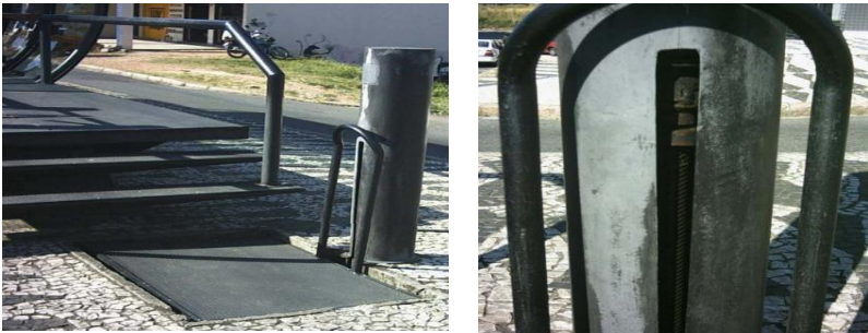
Figura 28: Plataforma elevatória. À direita, o fuso de esferas. Curitiba-PR.
