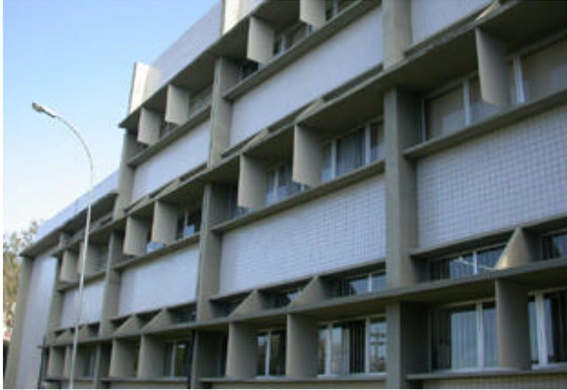
Fig. 3.10. Foto do prédio onde se localiza a sala 03, mostrando os elementos de controle e redirecionamento da luz natural.
