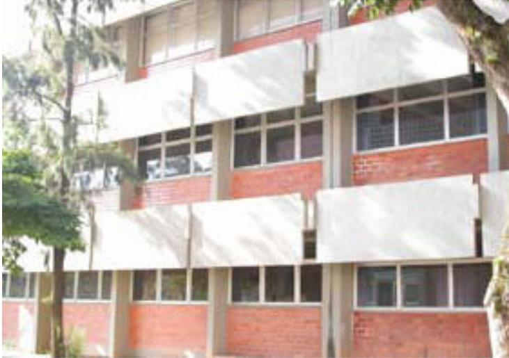
Fig. 3.7. Foto do prédio onde se localiza a sala 02, mostrando os elementos de controle.
