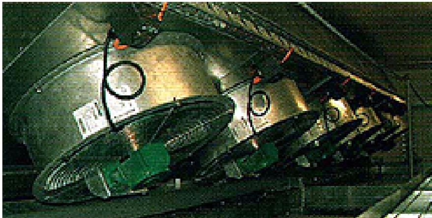
Figura 3: Evaporadores do *Air Chiller* da empresa Stork Bronswerk, em ângulo especialmente projetado.
