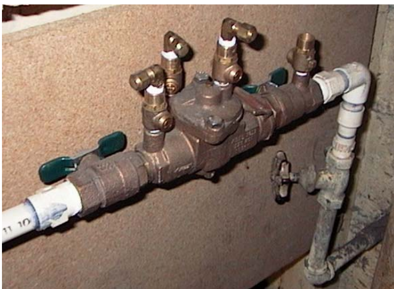
Figura 7: Válvula de Retenção para Prevenção do retorno da água de chuva
