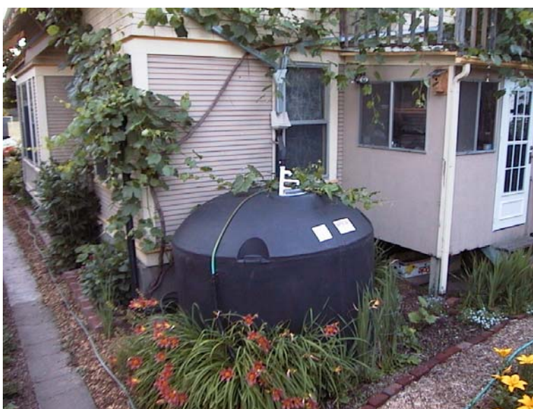
Figura 5: Sistema de Coleta de Água de Chuva: Cisterna de Plástico
