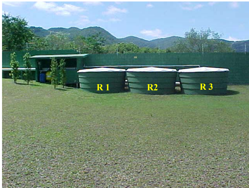
Figura 13: Reservatórios inferiores (cisternas)
