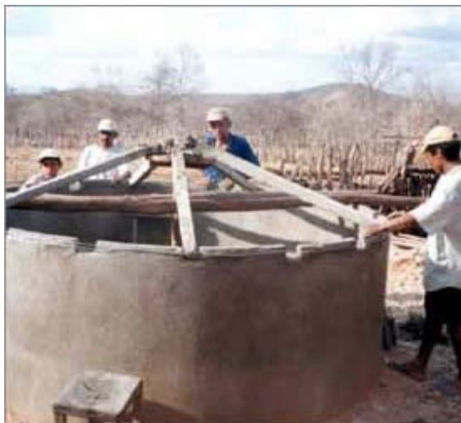
Figura 3: Construção de cisterna no Semi-Árido do Nordeste Brasileiro
