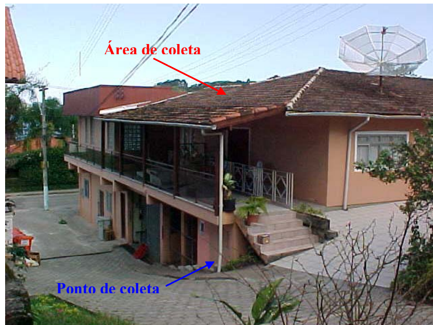
Figura 10: Residência de telhado cerâmico onde foi realizada a coleta das amostras
