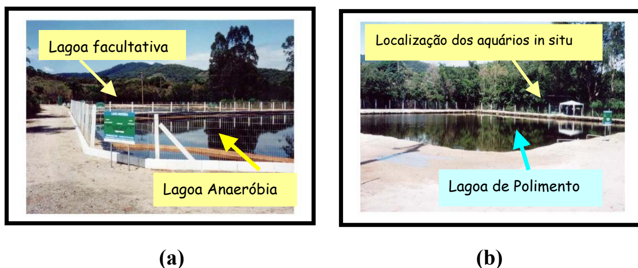
Figura 8 – (a) Esquema da Estação de Tratamento de Chorume do Aterro Sanitário onde foi realizada a pesquisa. (b) localização dos aquários in situ . Fonte: LabTox/ Vanessa Guimarães Machado.
