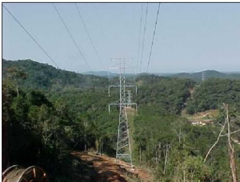
Fotografia 14 - Supressão da vegetação na faixa de servidão. Fonte: Eletrosul Centrais Elétricas S.A. (2002).
