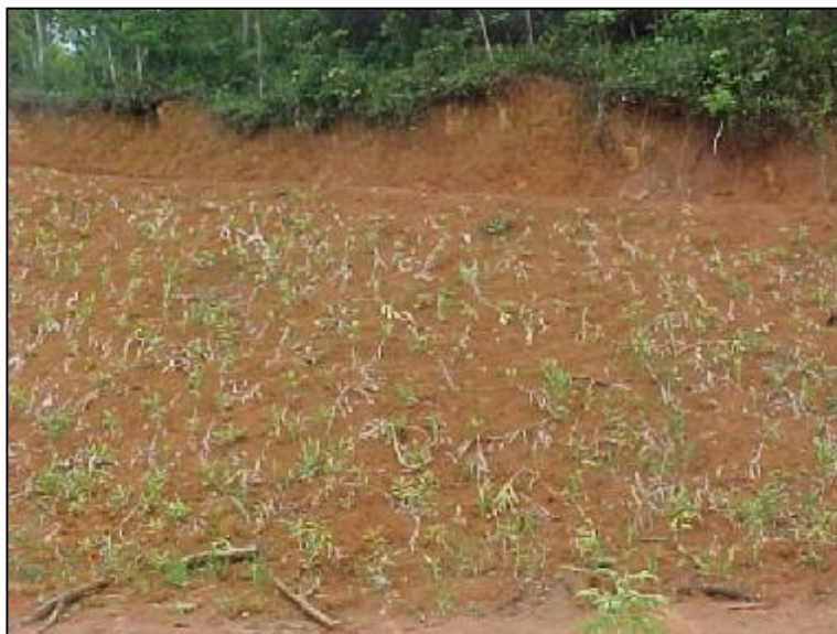
Fotografia 27 - Encosta recuperada. Fonte: Eletrosul Centrais Elétricas S.A. (2002).
