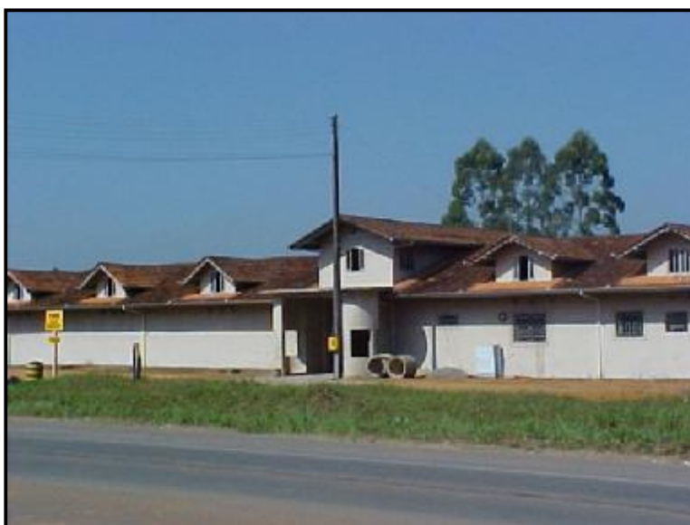
Fotografia 7 - Canteiro de obra. Fonte: Eletrosul Centrais Elétricas S.A. (2002).
