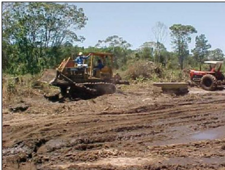
Fotografia 25 - Acesso sendo recuperado. Fonte: Eletrosul Centrais Elétricas S.A. (2002).
