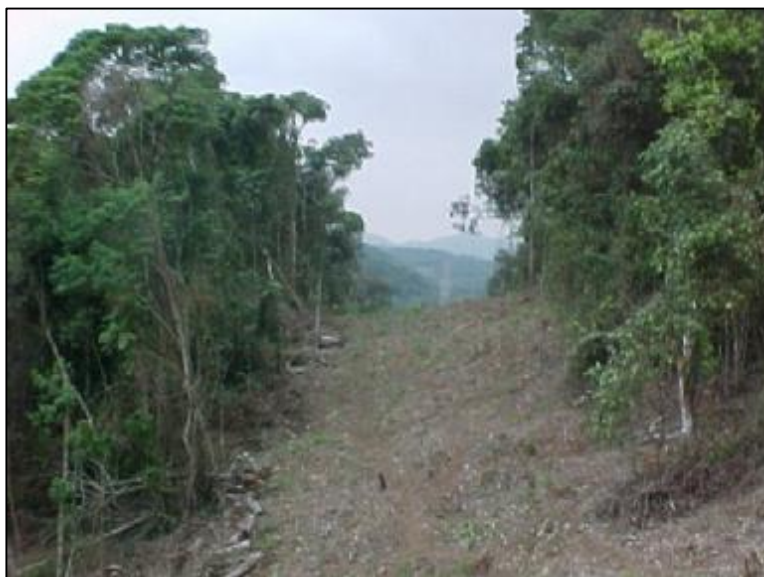
Fotografia 15 - Supressão da vegetação na faixa de servidão. Fonte: Eletrosul Centrais Elétricas S.A. (2002).
