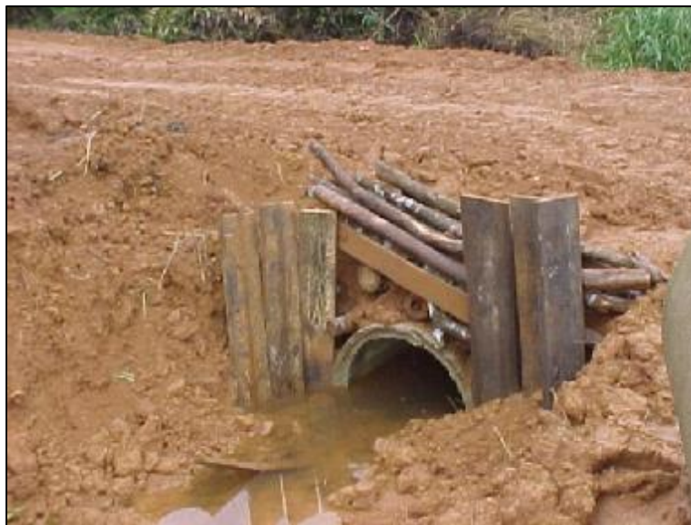
Fotografia 23 - Drenagem do acesso a ser recuperado. Fonte: Eletrosul Centrais Elétricas S.A. (2002).
