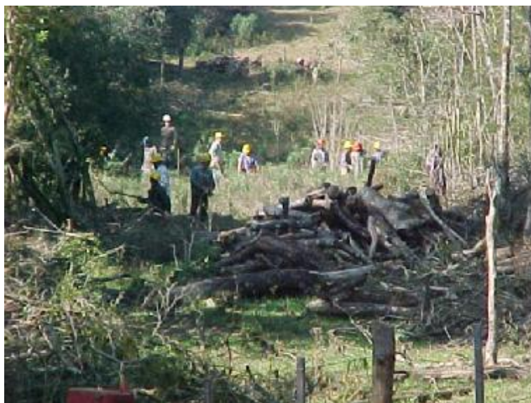
Fotografia:12 -Limpeza da faixa de servidão. Fonte: Eletrosul Centrais Elétricas S.A. (2002).
