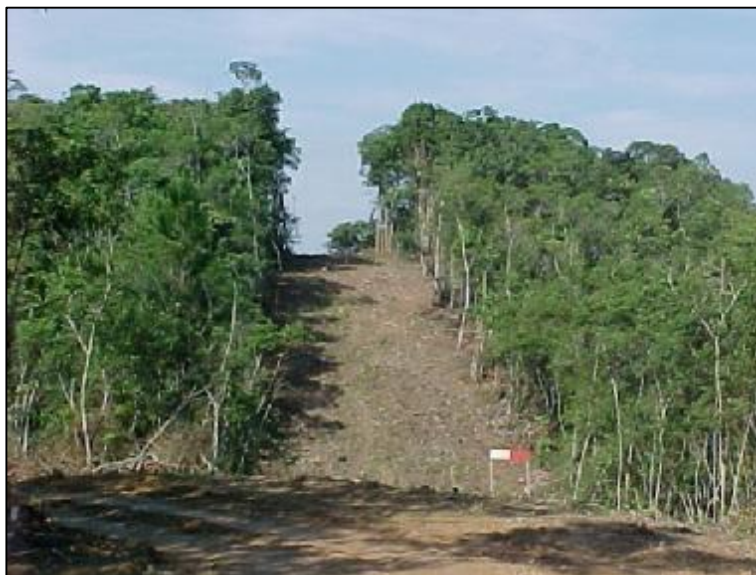
Fotografia 13 - Supressão da vegetação na faixa de servidão. Fonte: Eletrosul Centrais Elétricas S.A. (2002).
