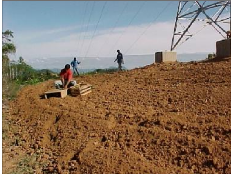
Fotografia 33 - A base da torre foi recuperada para evitar o processo erosivo. Fonte: Eletrosul Centrais Elétricas S.A. (2002).
