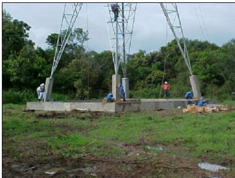
Fotografia 22 - Construção e Montagem da torre. Fonte: Eletrosul Centrais Elétricas S.A. (2002).
