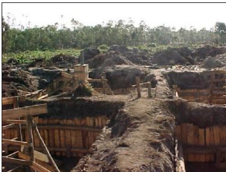
Fotografia 18 - Supressão da vegetação na faixa de servidão. Fonte: Eletrosul Centrais Elétricas S.A. (2002).
