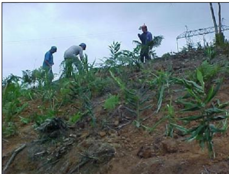
Fotografia 28 - Recuperação de encosta. Fonte: Eletrosul Centrais Elétricas S.A. (2002).
