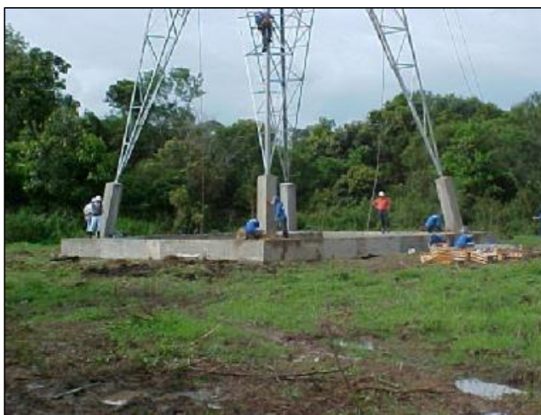
Fotografia 20 - Montagem da torre. Fonte: Eletrosul Centrais Elétricas S.A. (2002).
