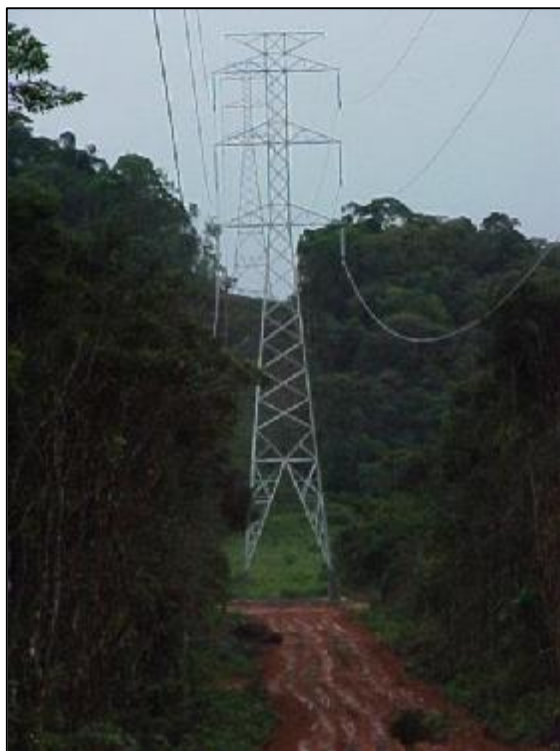
Fotografia 26 - Acesso para ser recuperado. Fonte: Eletrosul Centrais Elétricas S.A. (2002).
