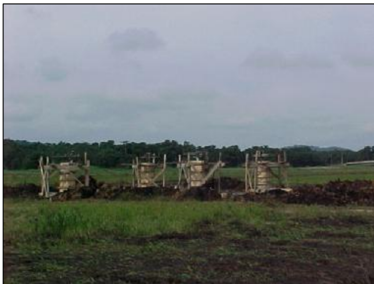
Fotografia 17 - Supressão da vegetação na faixa de servidão. Fonte: Eletrosul Centrais Elétricas S.A. (2002).
