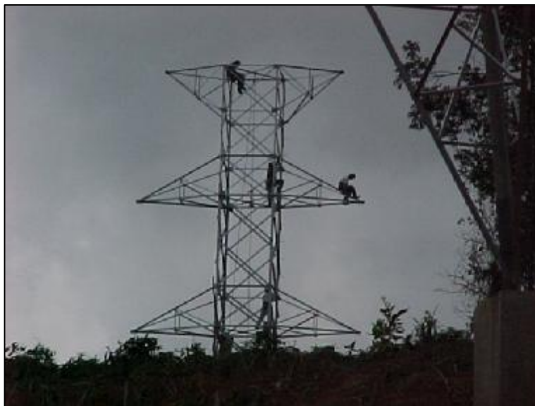
Fotografia 19 - Montagem da torre. Fonte: Eletrosul Centrais Elétricas S.A. (2002).
