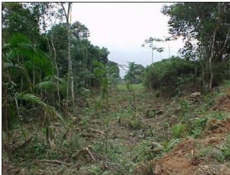
Fotografia 16 - Supressão da vegetação na faixa de servidão. Fonte: Eletrosul Centrais Elétricas S.A. (2002).
