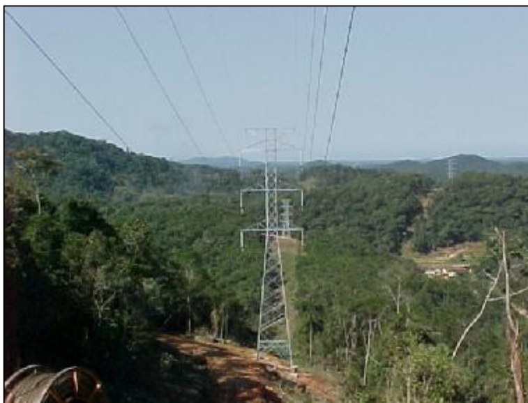
Fotografia 21 - Torre montada. Fonte: Eletrosul Centrais Elétricas S.A. (2002).
