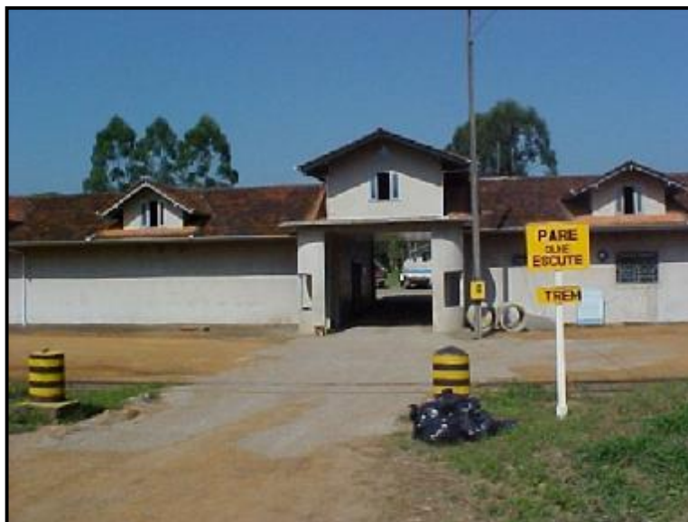
Fotografia: 6 - Canteiro de obra. Fonte: Eletrosul Centrais Elétricas S.A. (2002).
