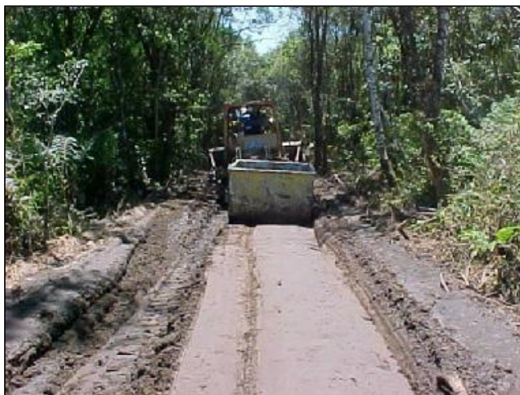
Fotografia 24 - Acesso sendo recuperado. Fonte: Eletrosul Centrais Elétricas S.A. (2002).
