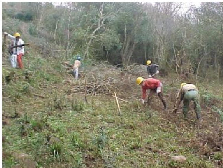
Fotografia 11 - Limpeza da faixa de servidão. Fonte: Eletrosul Centrais Elétricas S.A. (2002).
