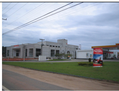
Figura 11 – Usos urbanos trecho 2 margem esquerda (Shopping de Decoração em construção)
