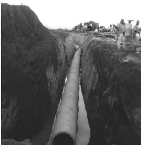
FIGURA 3 – Preenchimento de galeria de duto com argamassa fluida.
