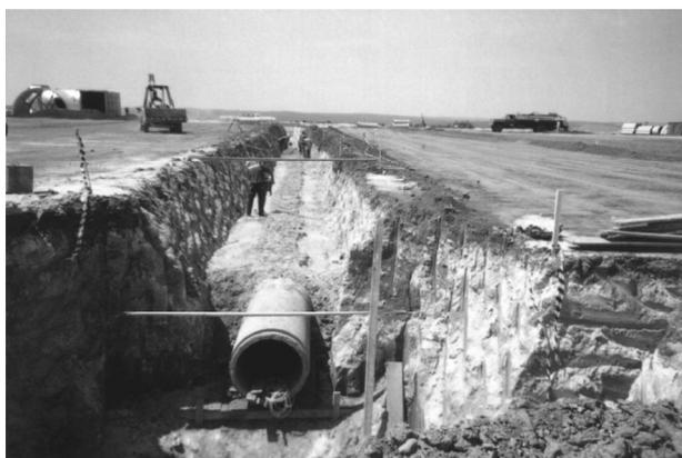
FIGURA 4 – Vista parcial do preenchimento da galeria sendo executado.
