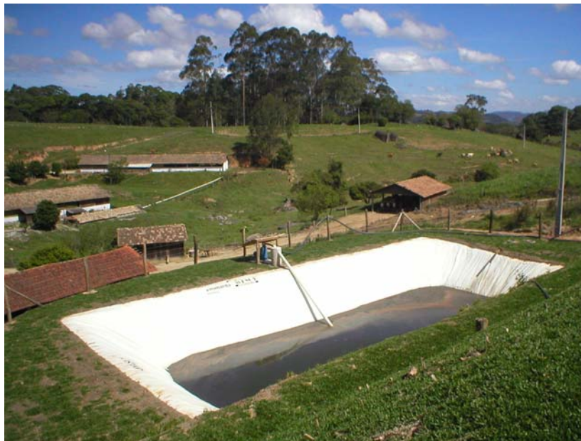
Figura 14: Vista da esterqueira 1, parte do sistema de tratamento de dejetos suínos, em Braço do Norte – SC.
