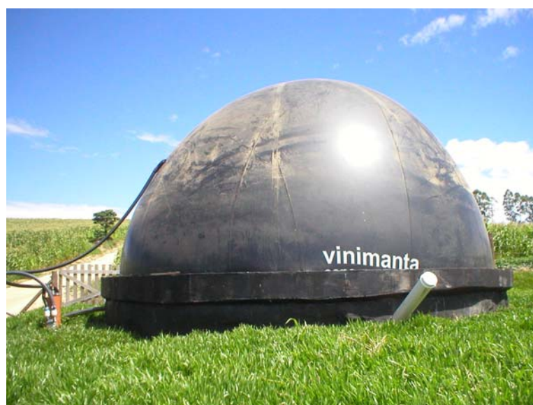
Figura 18: Vista do biodigestor, do selo hídrico e do gasômetro instalados na propriedade.
