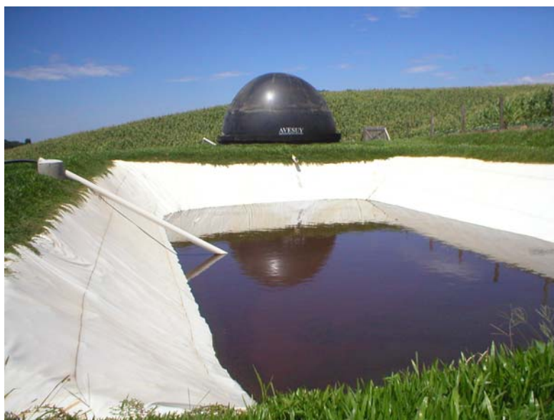
Figura 16: Vista do biodigestor (ao fundo) e da esterqueira 2, unidades da linha de tratamento 2, em pleno funcionamento em Braço do Norte – SC.
