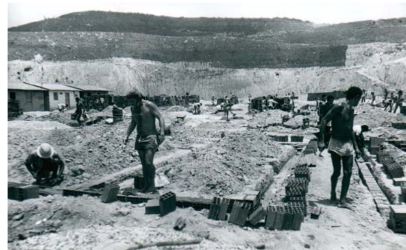
ILUSTRAÇÃO 42: Futuros moradores construindo os alicerces das casas. Ao fundo, os platôs vão surgindo de cima para baixo, parte mais baixa do morro desprovida de vegetação, aguardando as obras de contenção. Fonte: Selma Arteiro, [1990?].
