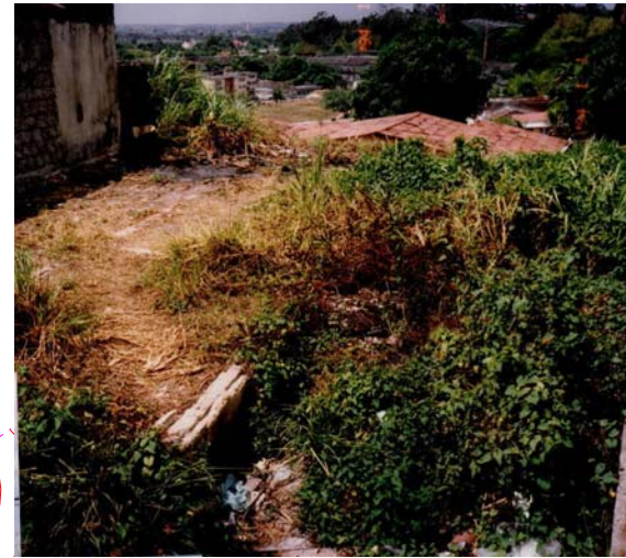
Casa sobre solo expansivo da Rua C. da Mata Machado, 865 foi condenada e demolida pela prefeitura. Família está no auxílio-moradia.
