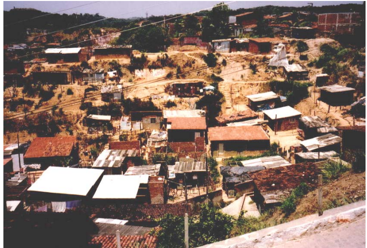
ILUSTRAÇÃO 75: Invasão de área remanescente próxima à subestação da CELPE. Fonte: foto da autora, 2005.
