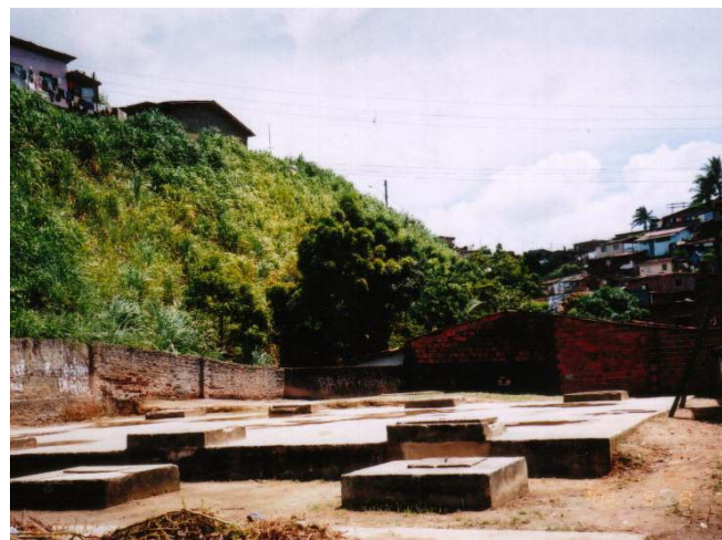
ILUSTRAÇÃO 80: Conjunto de fossas e filtros próximo à rua Antônio Carneiro. Fonte: foto da autora, 2005.
