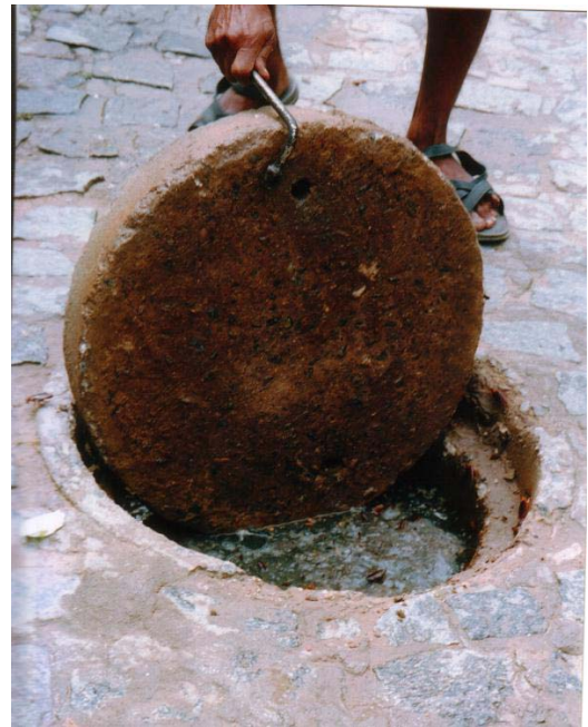
ILUSTRAÇÃO 69: Mesmo no período de estiagem, o esgoto está sempre trabalhando no nível máximo, dez/2004. Fonte: foto da autora.
