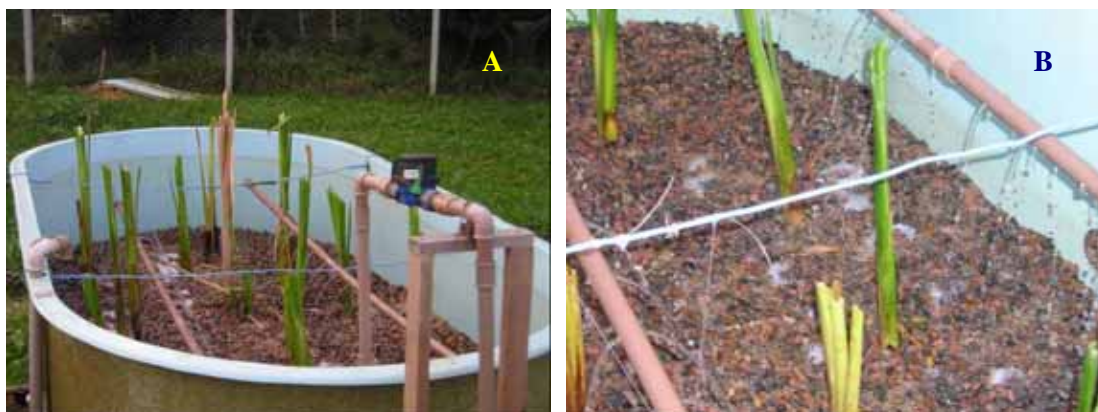
Figura 47: Controle da vazão de alimentação afluente. (A) detalhe do hidrômetro; (B) detalhe do momento da aplicação do afluente junto ao FPMv.
