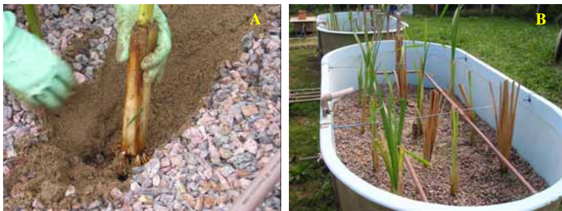
Figura 46: Plantio e adaptação das macrófitas. (A) detalhe do plantio manual; (B) detalhe das onze mudas de Typha domingensis em cada módulo FPMV.
