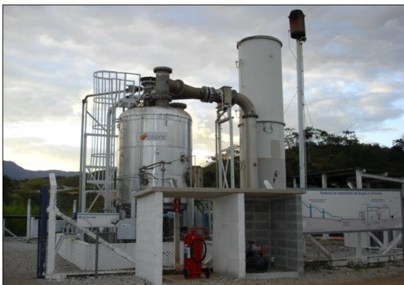
Figura 12 Evaporador de lixiviado instalado no aterro sanitário de Tremembé-SP
