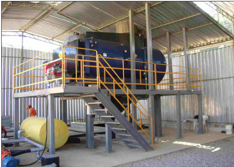
Figura 13 Evaporador de lixiviado instalado na CTR Nova Iguaçu – RJ.
