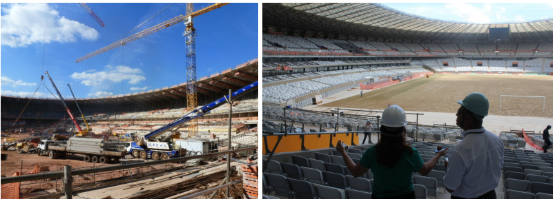
Figura 17 – Fotos da montagem da estrutura da nova cobertura do Estádio Mineirão – área de 58.287 m 2 .
