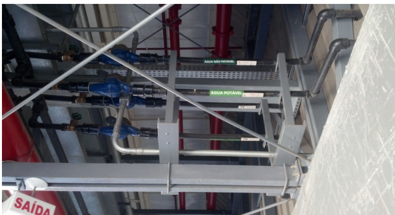
Figura 27 – Foto das redes independentes, inclusive registros, para água potável (P) e não potável (NP) nos galpões.
