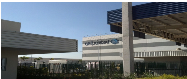
Figura 19 – Foto da entrada do condomínio logístico GR Jundiaí.
