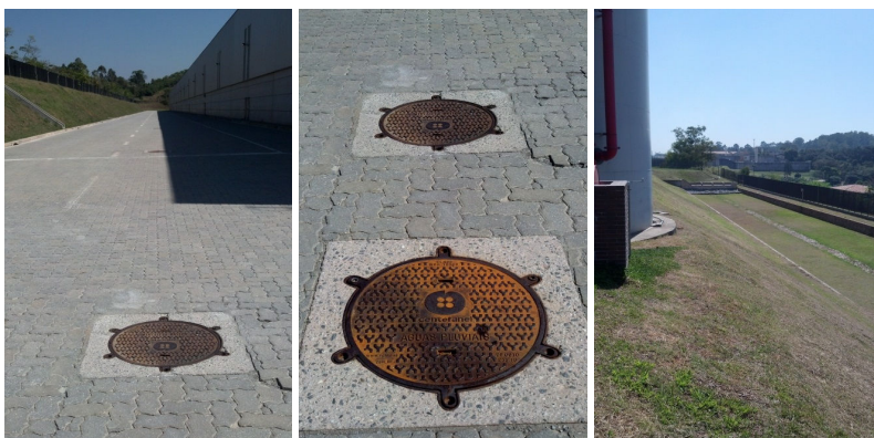
Figura 24 – Foto do pátio interno do Bloco C, onde há o reservatório de aduelas de concreto, o poço de visita e a lagoa de retenção com vertedouro para prevenção de enchentes.
