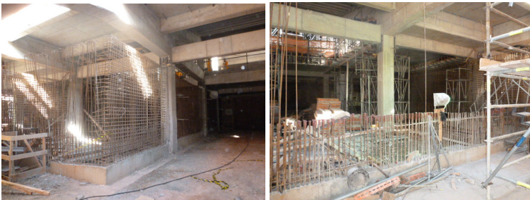
Figura 18 – Fotos da montagem da estrutura dos reservatórios de água de reuso abaixo das arquibancadas.
