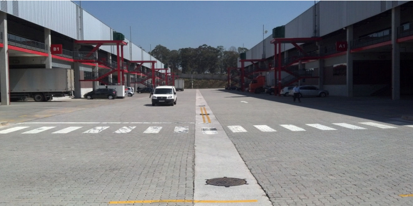
Figura 25 – Foto do pátio interno entre os Blocos B e A onde se vê a calha central de drenagem do piso.
