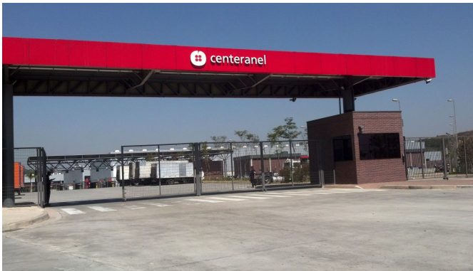
Figura 23 – Foto da entrada do condomínio logístico Centeranel.
