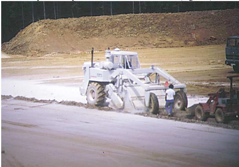
**Figura 5. Aplicação de bentonita em misturas com solo**
