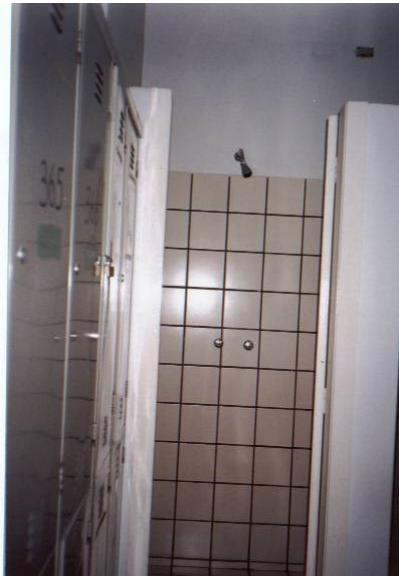
Fotografia nº 5 – Chuveiro de metal no HMMKB com registro de metal à meia altura da parede. Possui porta, pisos e paredes revestidos com material resistente, liso, impermeável e lavável
