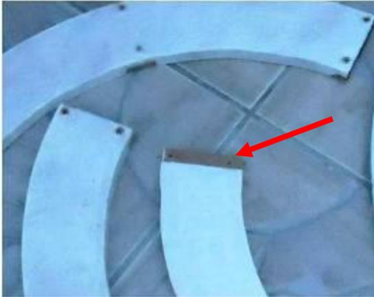
Foto 15. Rebaixo para encaixe das cambotas..
