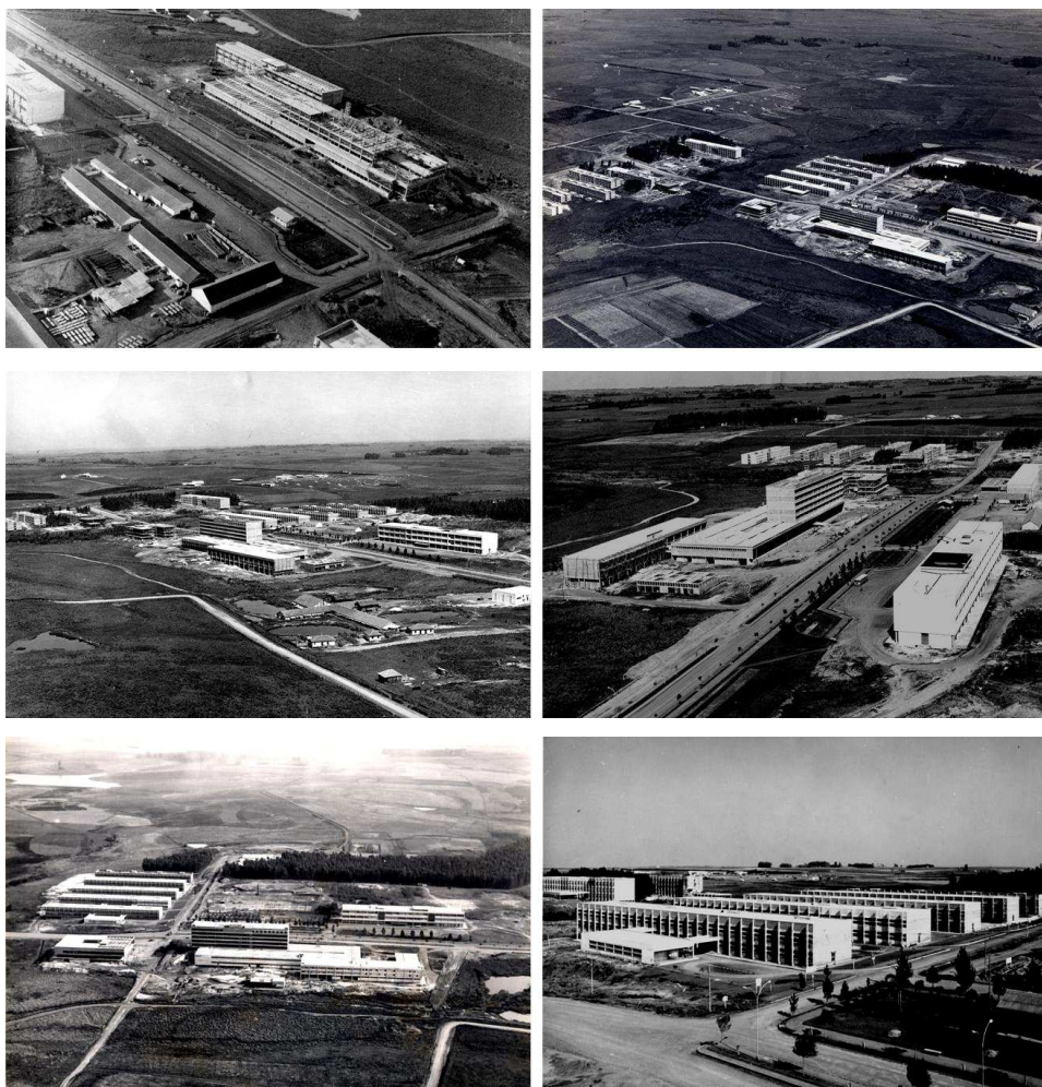
Figura 34. Fotos da construção do campus nos anos de 1966, 1967 e 1968. Fonte: Arquivo Central UFSM
