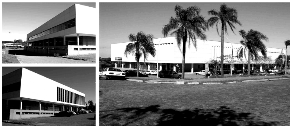
Figura 35. Biblioteca Central da UFSM Fonte: Arquivo do Autor
