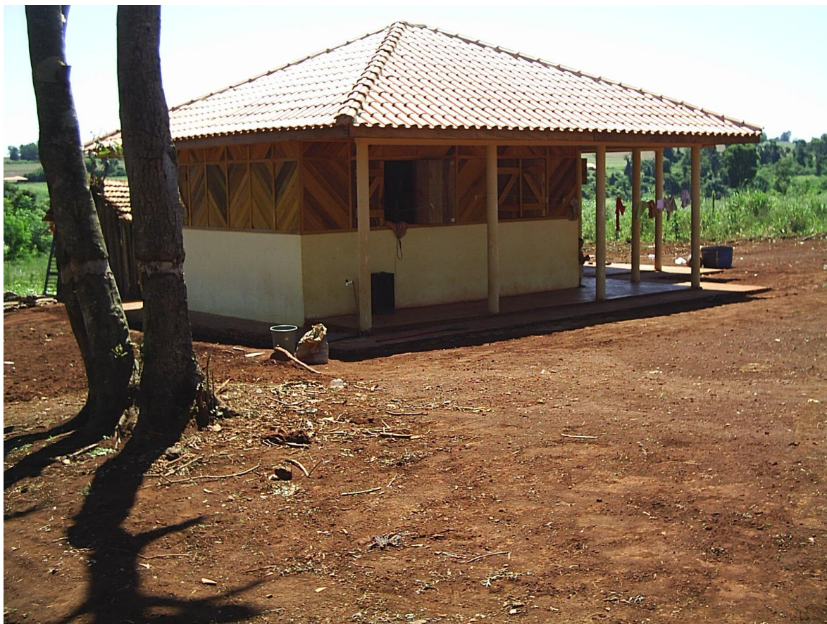
Foto 9: casa de alvenaria feita pelo projeto do governo do estado, “casa da família indígena”. Oco’y, fevereiro de 2006.
