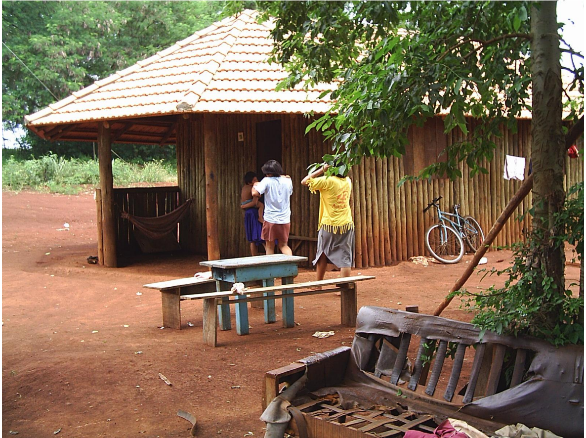
Foto 10: casa de madeira feita por um projeto da UH Itaipu Binacional. Oco'y, fevereiro de 2006.
