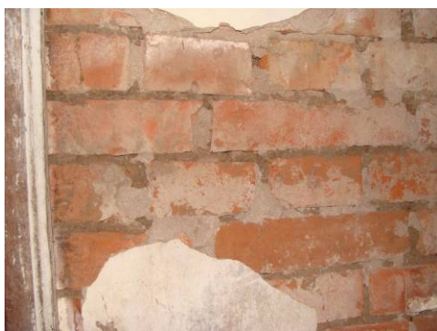
Fig. 43 e 44: Propriedade Ehrhardt: tijolos assentados com barro e a massa de cal nos rejuntas das fachadas exteriores. Fonte: Autor
