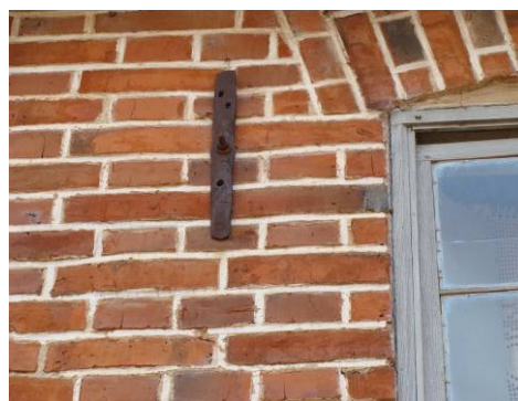
Fig. 43 e 44: Propriedade Ehrhardt: tijolos assentados com barro e a massa de cal nos rejuntas das fachadas exteriores. Fonte: Autor
