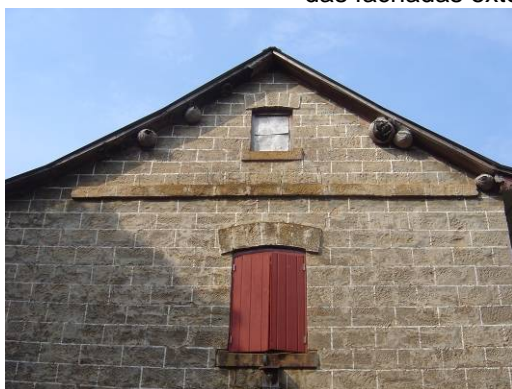
Fig. 45 e 46: Propriedade Steuernagel: pedras emparelhadas de arenito rejuntadas com barro e o reboco de cal com areia. Fonte: Autor
