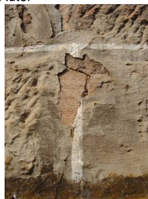
Fig. 45 e 46: Propriedade Steuernagel: pedras emparelhadas de arenito rejuntadas com barro e o reboco de cal com areia. Fonte: Autor
