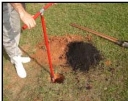
Figura 3 – Foto da escavação de um poço a trado manual.
