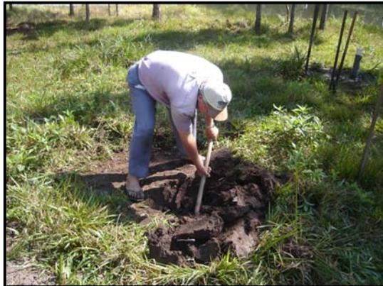
Figura 28 – Foto da perfuração dos poços de monitoramento.
