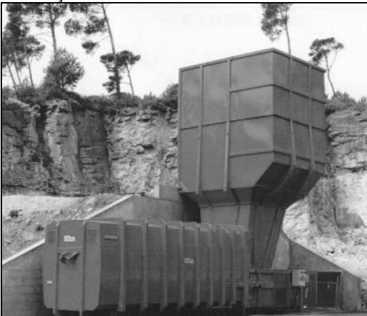
Figura 12- Estação combinada: Transferência direta com compactação.
