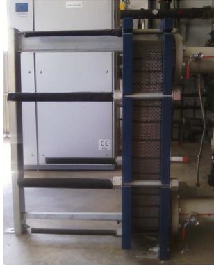
Fig. 2.17: trocador a placas 020 Plus
