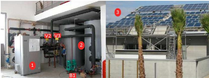
Fig. 4.1: planta solar de refrigeração. (1) Máquina de absorção, (2) Tanques de reserva, (3) Campo de coletores solares
