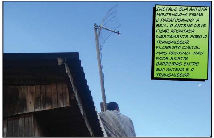
ÁRVORES, MUROS, CONSTRUÇÕES E BARREIRAS IMPEDEM QUE O SINAL CHEGUE COM QUALIDADE.
