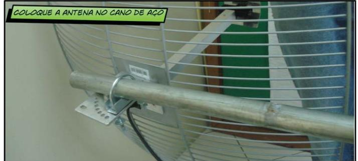
CUIDADO PARA NÃO COLOCAR A ANTENA NA PONTA DO CANO. DEIXE UM PEDAÇO SOBRANDO.
