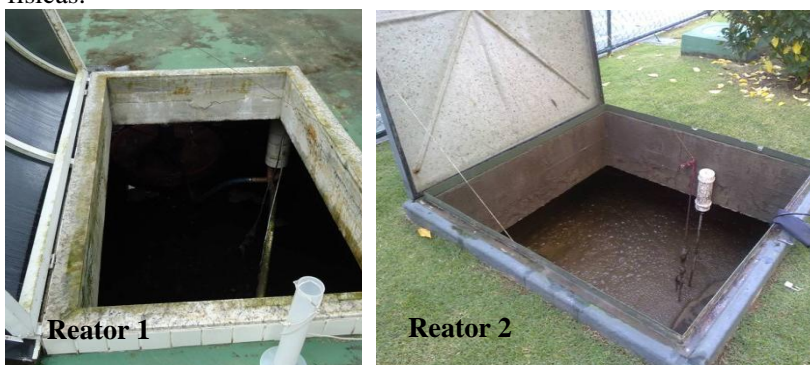
Figura 1: Reatores RBS em escala real, utilizados para tratamento biológico de esgoto sanitário.
