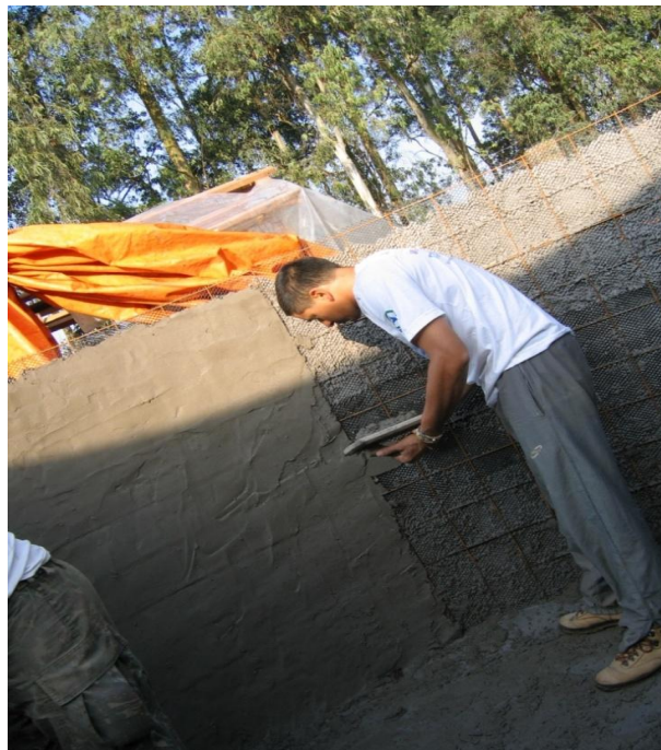
Fig. 4: Aplicação de argamassa na cisterna
