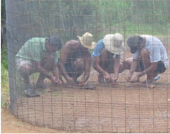
Fig. 2: Armação da cisterna
