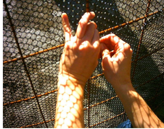
Fig. 3: Tela sendo colocada
