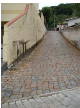
(c) Transversal da A. Tallmann, altura do Nº 353, ausência de passeios públicos.
