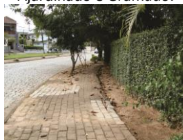
(h) Revestimento e Solo compactado.
