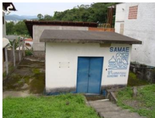
(d) Estação de recalque da SAMAE no final da rua Rio dos Cedros.
