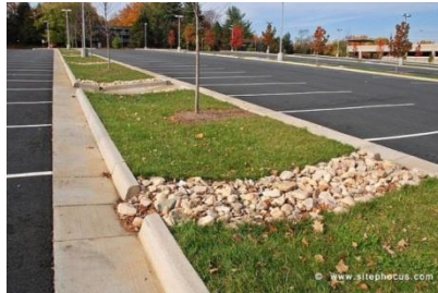
(b) Estacionamento arborizado e uso de sistema não convencional de drenagem pluvial (2007).
