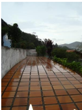
(a) Pavimentação em cerâmica, rua Adolfo Tallmann.
