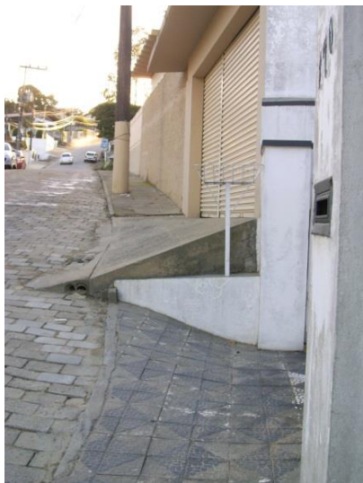
(c) Rampas de acesso à garagem sobre o passeio público.
