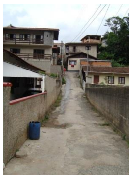
(d) Transversal da F. Deeke, altura do Nº 153, ausência de passeios públicos.
