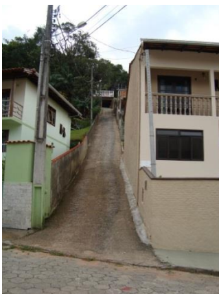
(e) Via transversal à rua Frederico Deeke, altura do Nº 160, com garagem edificada sobre a pista.
