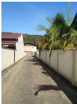
(b) Pavimentação em lajota sextava de concreto, rua Carlos Rischbieter.
