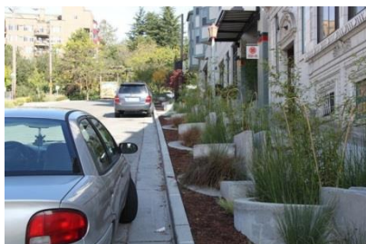
(a) Canteiro Pluvial, Seattle .
