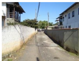
(b) Rua Francisca Perkowsky, ausência de passeios públicos.
