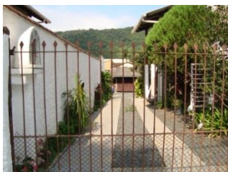
(a) Pavimentação em concreto desempenado in loco e brita, rua Carlos Rischbieter, Nº 1488.
