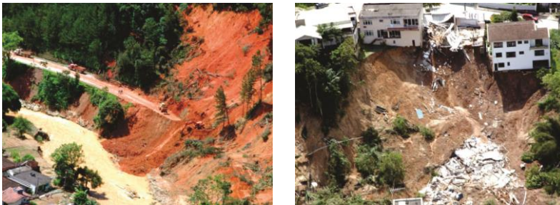
(a) Rua Progresso, Progresso.
