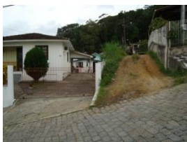
(a) Rua João Gonçalves, ausência de passeios públicos.
