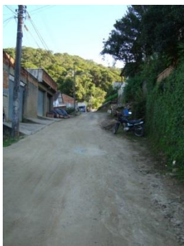
(e) Rua Geraldo João da Silva, passeios públicos isolados.
