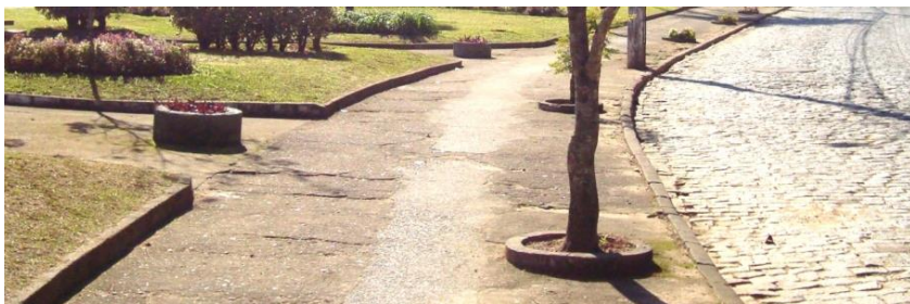
(c) Passeio público arborizado, mas com caixa de árvore menor do que 90 cm por 90 cm e borda elevada.
