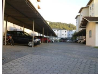
(b) Condomínio Residencial Boa Vista.
