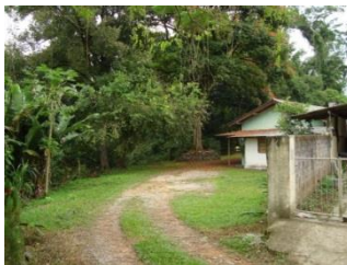
(b) Solo compactado exposto, rua Carlos Rischbieter, Nº 2218.
