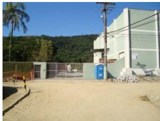
(b) Portão eletrônico no final da rua Otto Stutzer.
