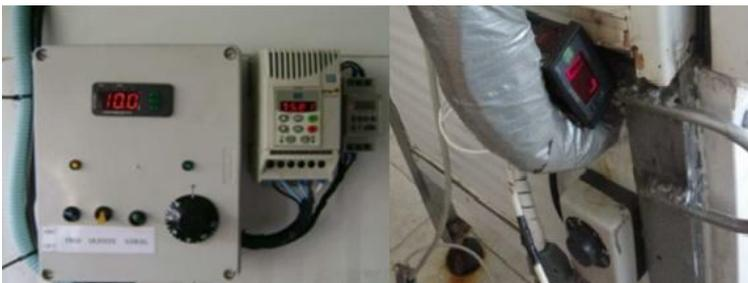
**Figura 5.41** – Controladores de temperatura e inversor de frequência.
