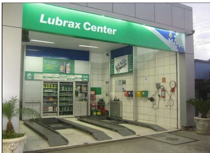
Figura 9. Imagem de uma instalação destinada à troca de óleos e filtros veiculares em posto de abastecimento de combustíveis.
