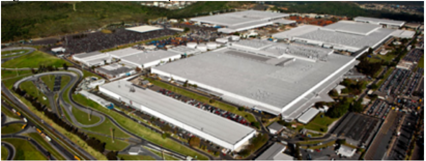
Figura 1 - Vista aérea do complexo industrial
