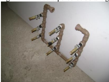
Figura 1 - Bicos aspersores do antigo sistema.
