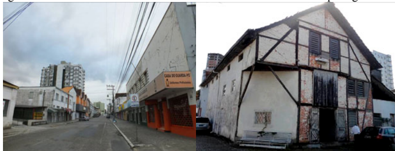
Figuras 214 e 215 - Permanência de casas comerciais. Ponto tomada paisagem: 51 ›
