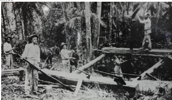
Figura 27 - Abertura da mata e corte das madeiras para a edificação de moradias dos imigrantes
