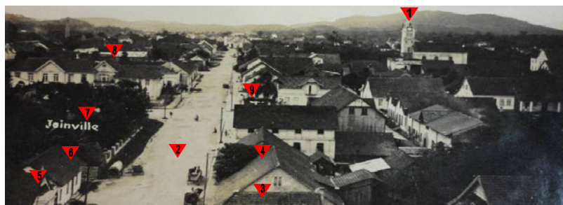
1. Igreja luterana. 2. Rua do Norte – atual Rua Dr. João Colin esquina com Rua do Meio – atual Rua 15 de Novembro. 3. Secos e Molhados. 4. Alfaiataria. 5. Residência e funilaria. 6. Residência. 7. Residência e Comércio. 8. Residência de ervateiro – 1917 (depois Grande Hotel Joinville). 9. Residência de ervateiro. Fonte: AHJ.
