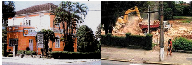
Figuras 436 e 436/A - Demolição em 2004 de edificação com valor patrimonial – Casarão Timm/ Rua Nove de Março
