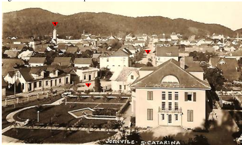
Figura 38 - Rua do Meio – parcial eixo centro e norte
