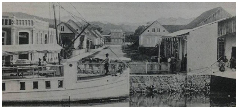
Fig. 394 - À esquerda da figura acima, escritório de Hans Jordan e Gerken de comercialização da erva-mate. À direita, atracadouro da Companhia de Navegação para passageiros (Joinville/São Francisco do Sul) e mais tarde escritório de beneficiamento da erva-mate de Wolf & Cia. Fonte dados e imagem acima: AHJ. Ao centro, a atual Rua 7 de Setembro.
