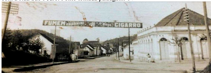
Figura 318 - Início da Rua Catharina — Atual Avenida Getúlio Vargas, esquina com a Rua São Pedro. Ponto tomada paisagem: 1 ›
