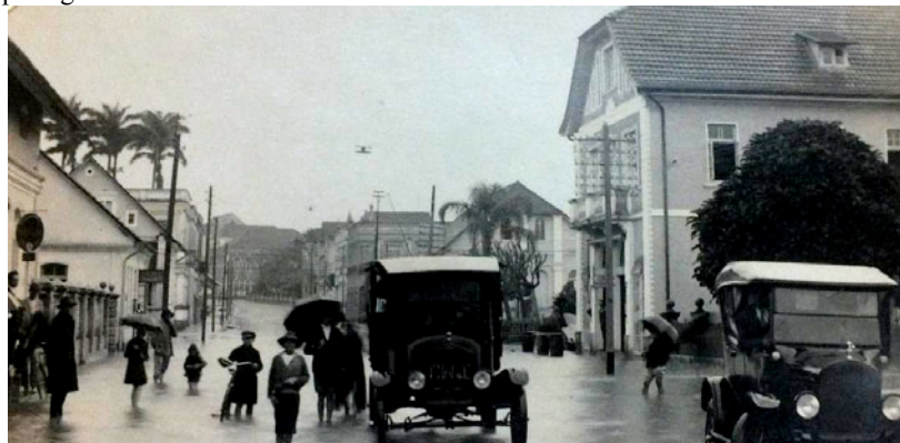
Figura 115 - Escola Remington e escritório do Moinho Joinville. Ponto tomada paisagem: 23 >
