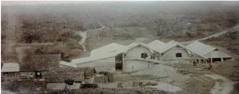
Fig. 7 - Companhia Industrial de A. Batista - Fábrica de cal - Ribeira. Verificando a figura de n. 06 acima, nota-se a presença dos mesmos fornos de cal, tendo ao fundo a Baía da Babitonga. Fonte: AHJ.
