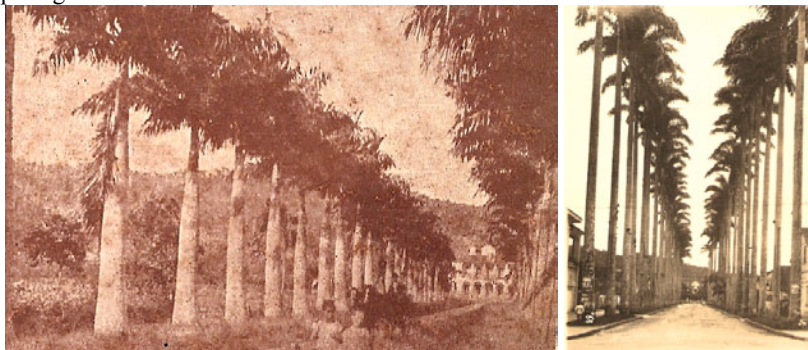
Fig. 168 - Fonte: Lembranças de Joinville (1951). [Estimativa da autora: meados de 1870, data de quando foi edificado o Palácio dos Príncipes, passando a tomar parte na paisagem]. Fig. 169 - Caminho inicial recebe o tratamento de rua e calçadas na segunda década do século XX. Fonte: AHJ, 1929.
