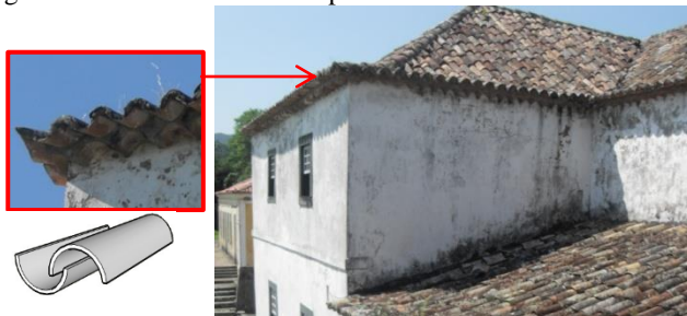
Figura 39 – Telhado sistema capa e canal com telhas coloniais e beira-seveira
