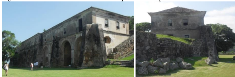
Figura 66 – Fachadas laterais e leste do quartel da tropa
