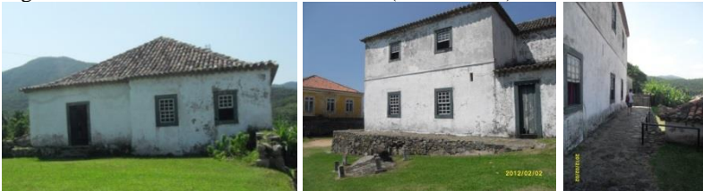
Figura 65– Fachadas dos fundos e laterais (oeste e leste)
