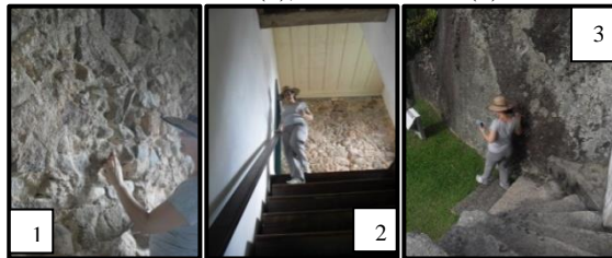
Figura H – Parede reembrechada (1), escada interna (2) e externa (3) do paiol
