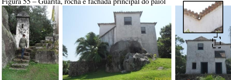
Figura 55 – Guarita, rocha e fachada principal do paiol
