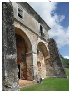
janelas e contraforte
