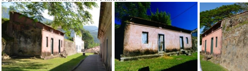
Figura 62 – Cozinhas. Fachada e laterais
