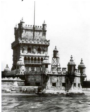
Figura 03 - Torre de Belém; Transição: Torre + baluarte
