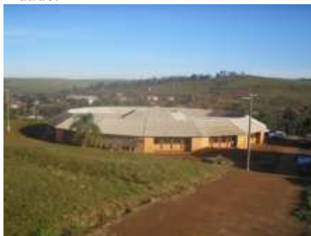
Figura 03: Escola em formato arredondado.
