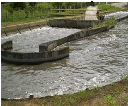
Figura 18 – Valo de Oxidação Sistema 1 Fonte: A autora (2013)
