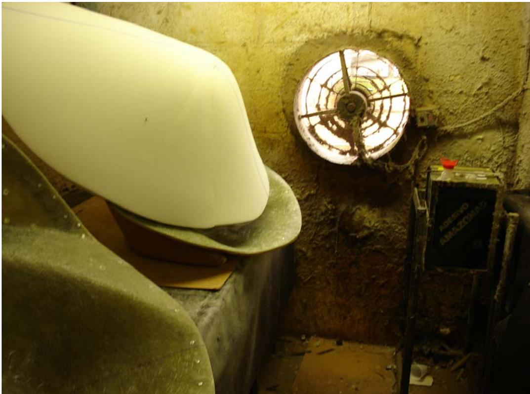
**Figura 33:** Vista de um exaustor com depósito de partículas.
