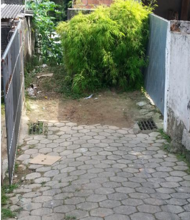
Figura 12 – Local para a implantação da elevatória na Serv. Madre Paulina
