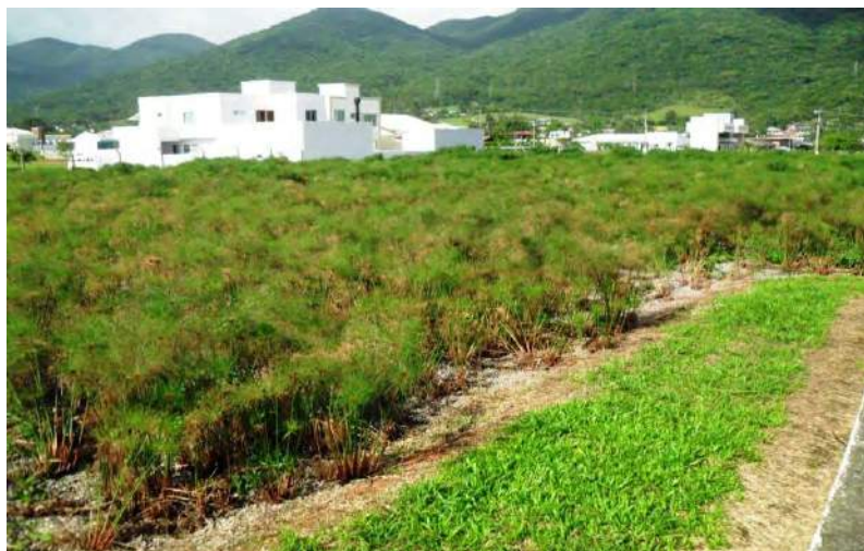
Figura 9 Wetland construído de fluxo vertical (WCFV) plantado com Cyperus papyrus
