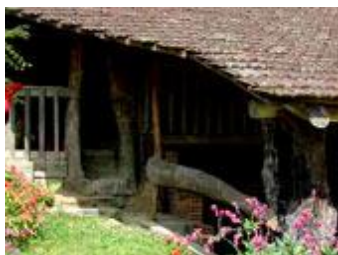
Entrada do Refeitório
