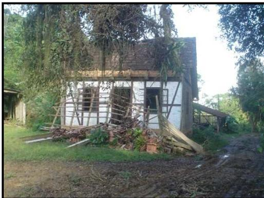
Fig. 60 – Casa Enxaimel do Campus com beiral parcialmente destruído.
