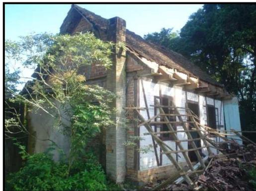
Fig. 61 – Detalhe do Beiral da Casa Enxaimel do Campus parcialmente destruído.
