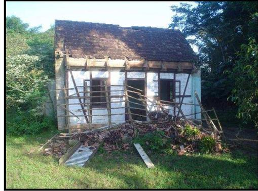
Fig. 63 – Casa Enxaimel do Campus com beiral parcialmente destruído.
