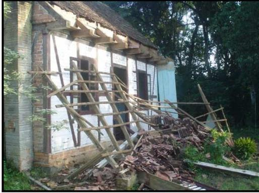
Fig. 62 – Detalhe do Beiral da Casa Enxaimel do Campus parcialmente destruído.
