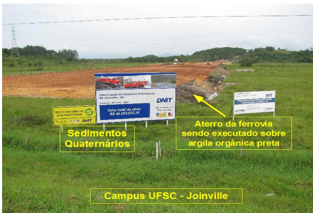
Figura 3.5.30: Aterro do Contorno Ferroviário executado sobre Sedimentos Quaternários, formados por uma argila orgânica preta
