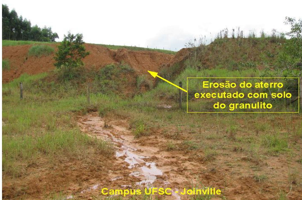
Figura 3.5.20: A sensibilidade à erosão do horizonte C do granulito se manifesta também em taludes de aterros executados com este solo
