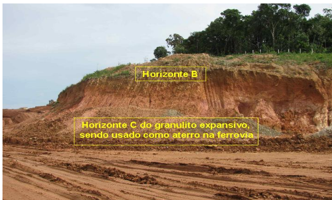
Figura 3.5.18: Área de empréstimo próxima ao campus, utilizada para o aterro do Contorno Ferroviário, formado pelos horizontes B e C de granulito
