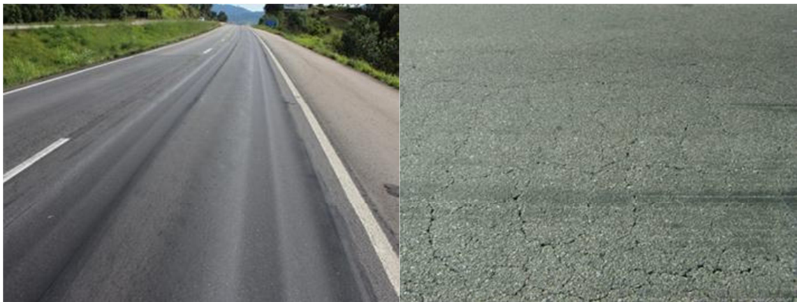
Figura 17 - Trilha de roda observada na BR 101, em Imbituba (SC), com apenas 2 anos de abertura ao tráfego. Trincamento observado em Paulo Lopes com apenas 3 anos de abertura ao tráfego.
