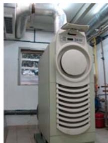
Microturbina 28 kWel
